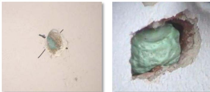
Orificios de inyección rellenos, antes del sellado
