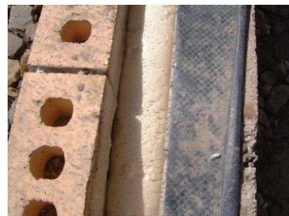
La inyección se realiza con un sistema específico de celda abierta y baja densidad
