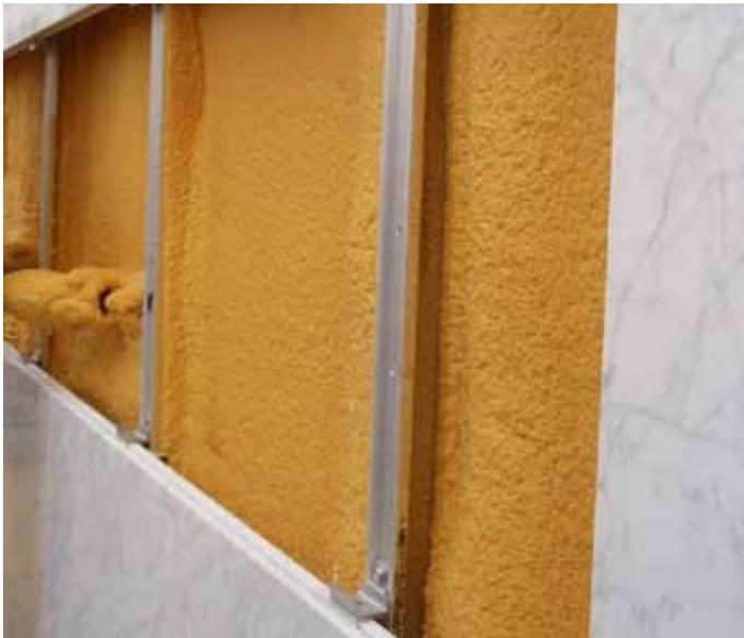
Detalle de colocación de aplacado de mármol en nueva fachada
