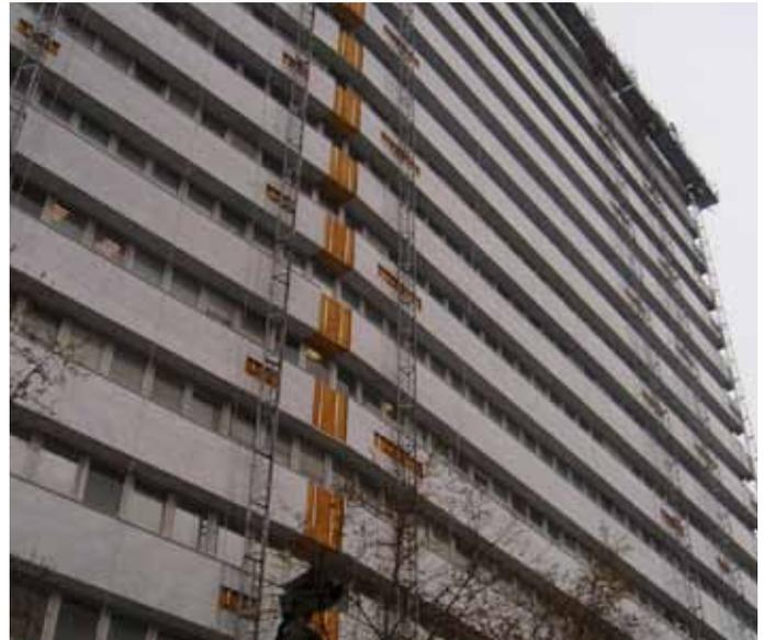
Resultado avanzado de colocación de mármol en fachada
