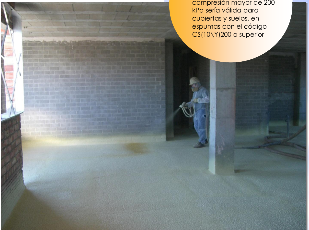
Proyección de poliuretano con una resistencia a compresión mayor de 200 kPa en el suelo de la planta baja.
