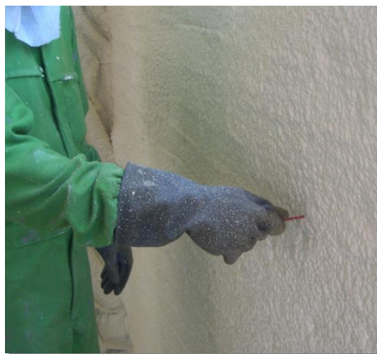
El ensayo de medición del espesor se realizará al menos cada 100 m 2 .
