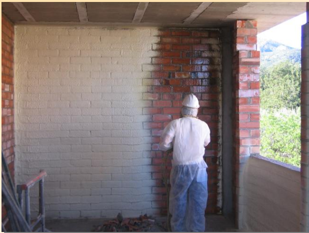
El grosor de poliuretano proyectado dependerá de la zona climática y de la composición del cerramiento
