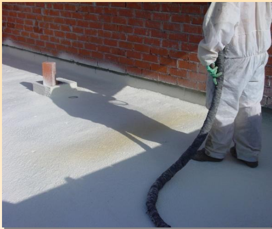
Cubierta transitable proyectada con espuma de poliuretano
