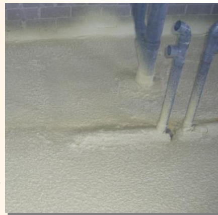
Tuberías e instalaciones quedan envueltas por el poliuretano proyectado
