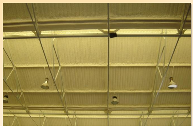
Cubierta de chapa aislada con poliuretano
