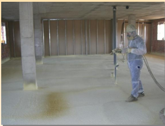
Capa continua de poliuretano proyectado en el suelo, antes del solado
