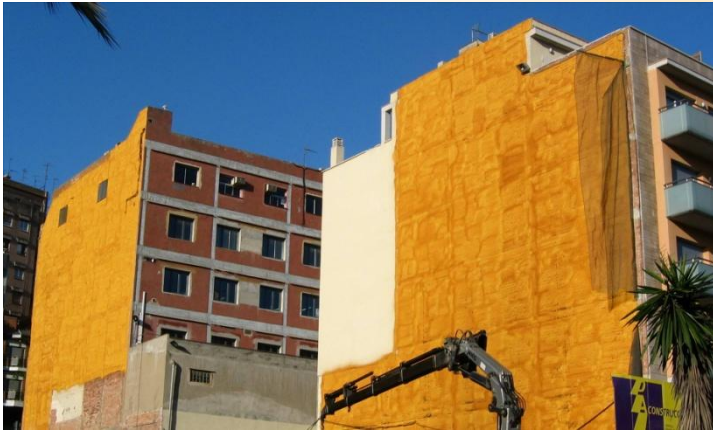
Medianeras aisladas e impermeabilizadas con poliuretano proyectado, antes de recibir la protección UV.
