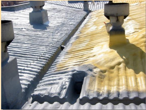
Proyección por el exterior, y protección UV.
