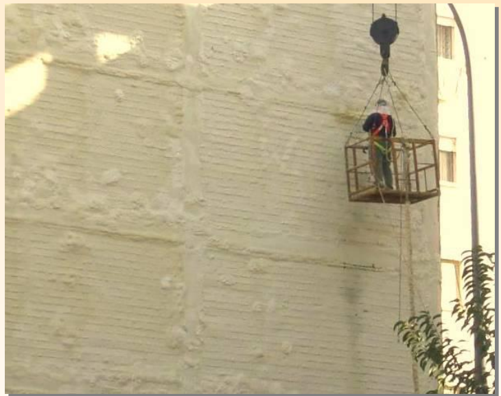
Una protección posterior de la espuma con una pintura o un elastómero prolongará la vida del aislamiento y sus prestaciones.
