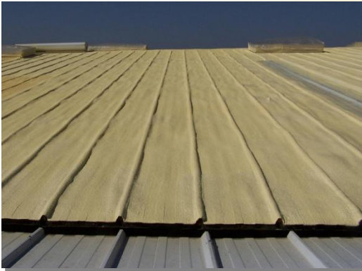
Proyección por el exterior antes de la protección UV.
