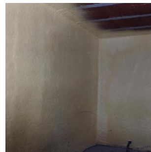
Detalle del lienzo tras la proyección de espuma de poliuretano.
