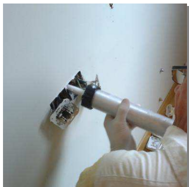
Preparación del cerramiento
