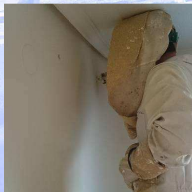
Inyección de poliuretano
