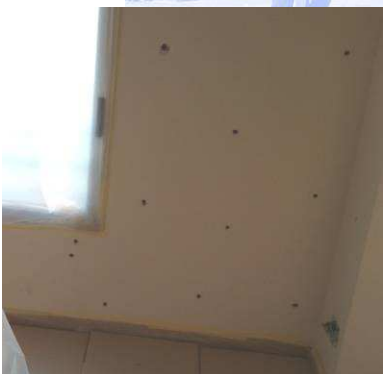
Ejecución de taladros
