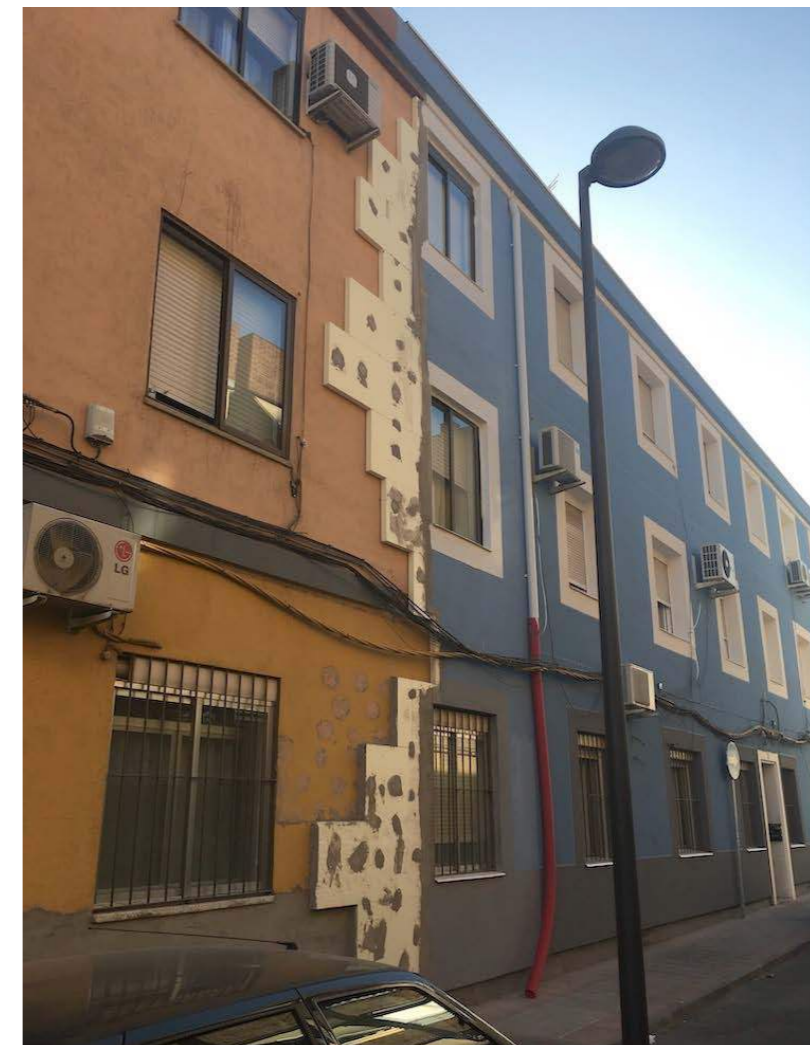
Fig. 17. Sistema SATE aplicado durante la rehabilitación de un edificio de viviendas. Izquierda: estado sin rehabilitar. Derecha: estado rehabilitado.
