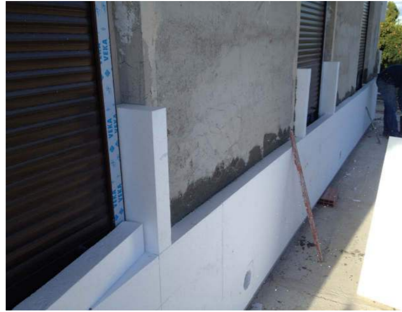
Fig. 5. Aplicación del sistema de aislamiento térmico por el exterior SATE - ETICs
