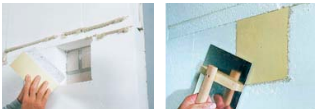
Figura 45. Instalación de un elemento de fijación para una carga pesada
