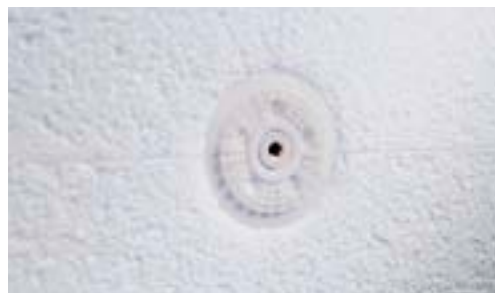
Figura 6. Detalle de la instalación de una espiga sobre el aislamiento
