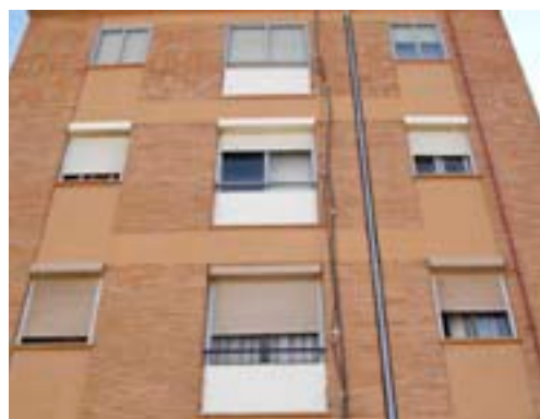
Figura 3. Fotografía de una fachada con conducciones exteriores antes de rehabilitar
