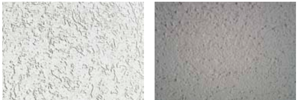
Figura 33. Textura de un revoque acanalado remolinado y acanalado horizontal
