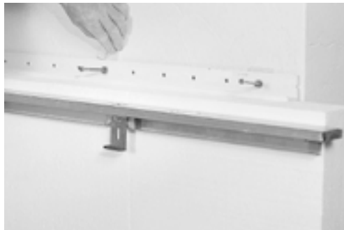
Figura 16. Fotografía de la instalación de un listón de retención
