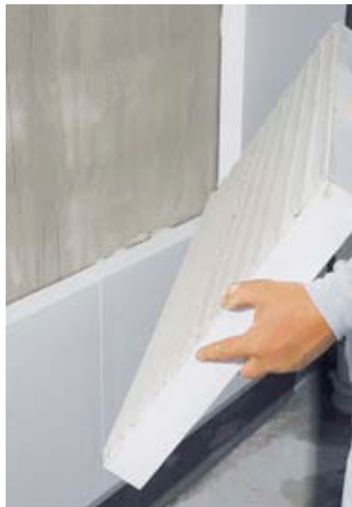
Figura 5. Detalle del pegado de una plancha de aislamiento en toda la superficie
