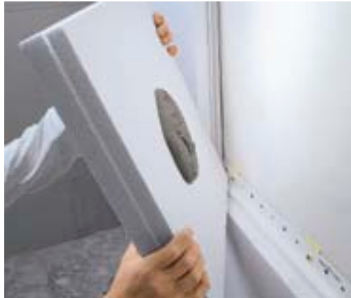
Figura 13. Fotografía del pegado de los paneles de aislamiento
