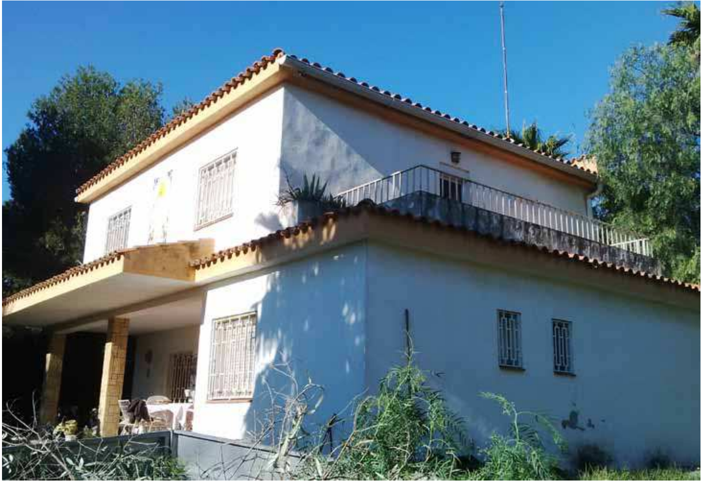
Estado inicial, antes de la rehabilitación
