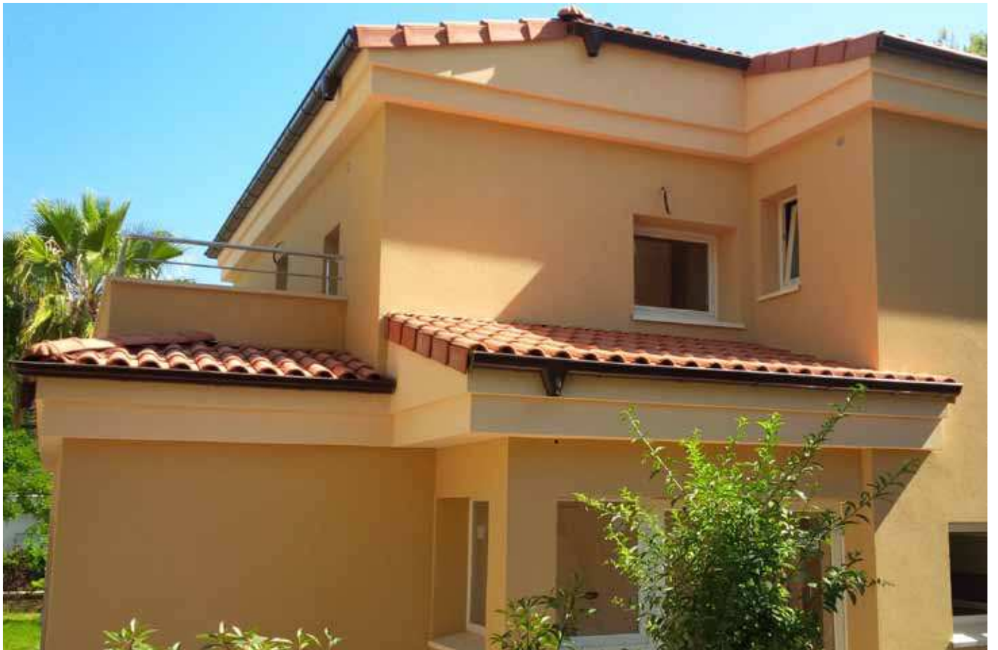
Obra finalizada, vivienda rehabilitada
