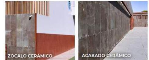
Finalmente, para la realización del rejuntado de todas las baldosas cerámicas, se utilizó el mortero de altas prestaciones, modificado con polímeros, antieflorescente, para el relleno de juntas de hasta 20 mm, de fraguado y secado rápidos y tiempo breve de espera para la puesta en servicio del revestimiento, sin retracciones ni grietas ni fisuras, **ULTRACOLOR PLUS**, clasificado según la EN 13888 como clase CG2WA.
