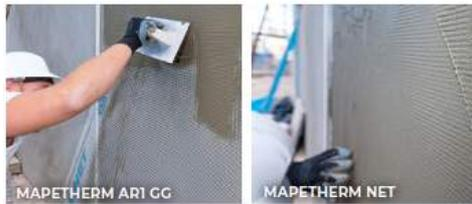
Transcurridas 24 horas, cuando estuvo seca la primera capa, se procedió a la aplicación de la segunda capa, de un espesor de aproximadamente 1,5 mm, formando un estrato homogéneo y uniforme en el cual la malla quedó completamente embebida y cubierta.
